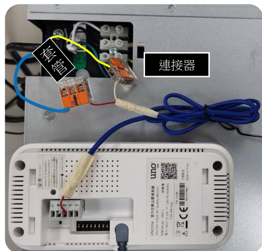
暖風機接線方式 (以VHB30ACMT-BLED為例)
